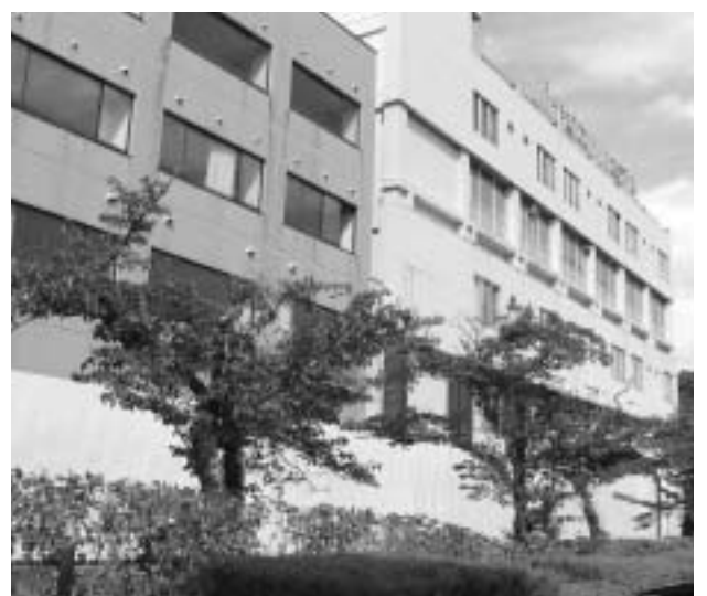
仮囲いされた旧ホテル
