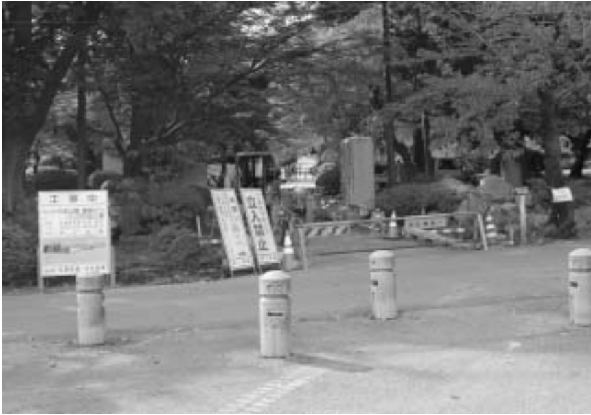
園路入口のバリアフリー工事
