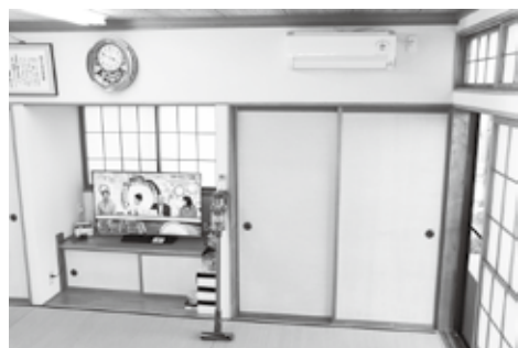
▲エアコンが設置された观音寺公会堂
