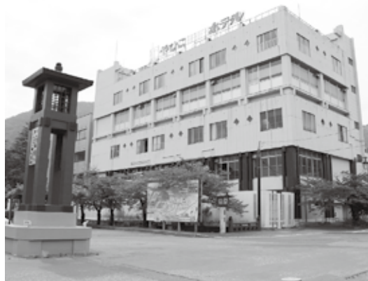
解体予定の旧やひこ観光ホテル
