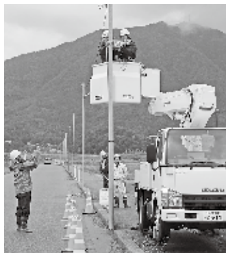
▲防犯カメラ設置の様子
