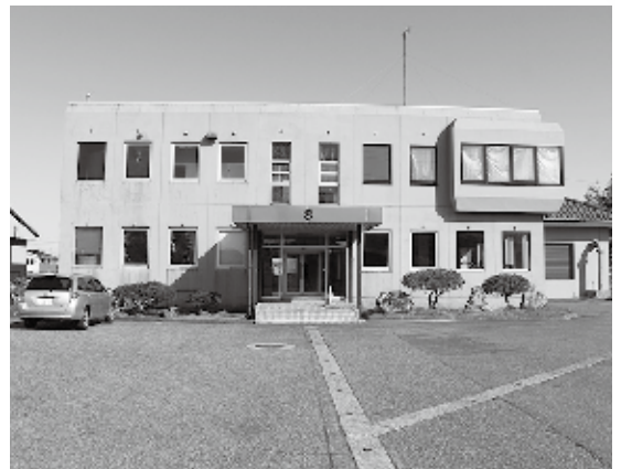
耐震化工事の必要な管理棟（弥彦村）
