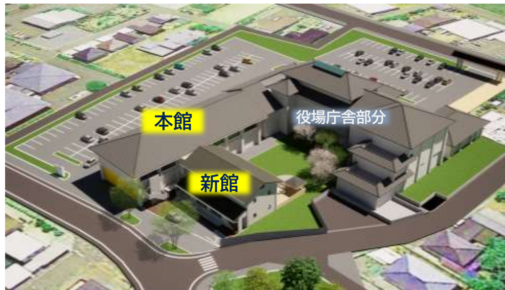
北側方向から
