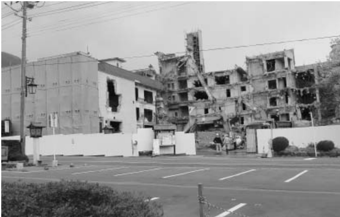
解体工事が進むグランドホテル
