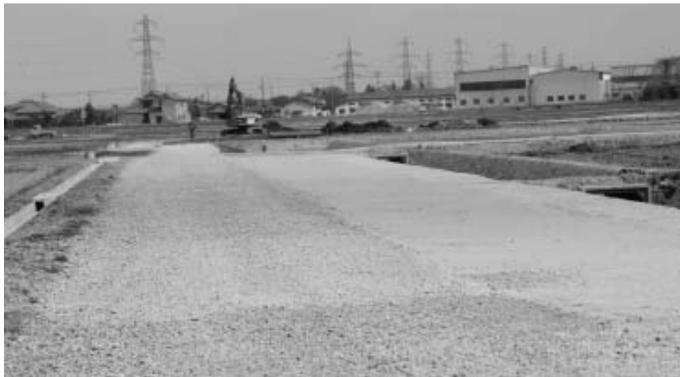
美山大戸線（藤見線）に着工
