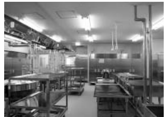
ドライ化改修された小学校調理室
