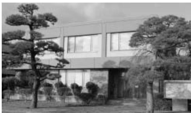
移転工事中の旧弥彦支所
