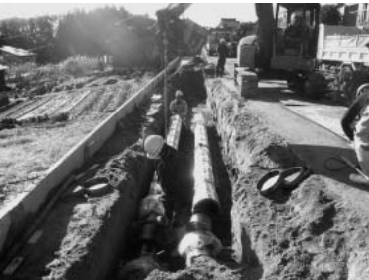
高区送水管布設工事（上泉地内）
