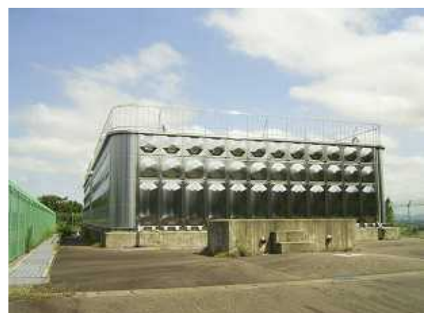
低区ステンレス配水池
