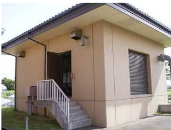
送水ポンプ室全景
