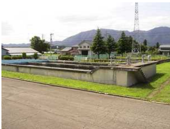
第 1 薬品沈殿池全景
