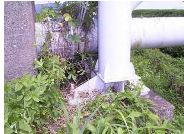
矢川水管橋左岸橋台部
