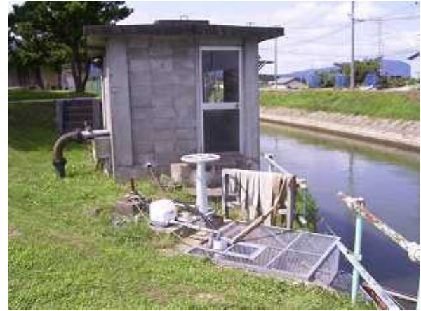
西川取水口近景
