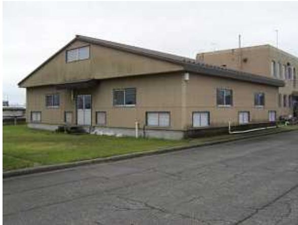
急速ろ過池全景
