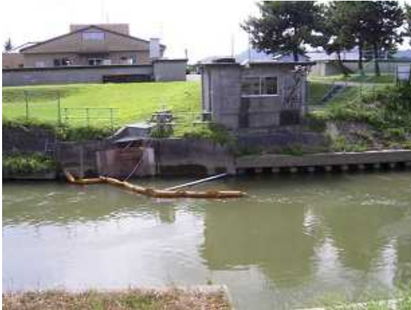
西川取水口全景
