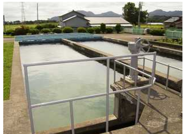
第 1 薬品沈殿池近景
