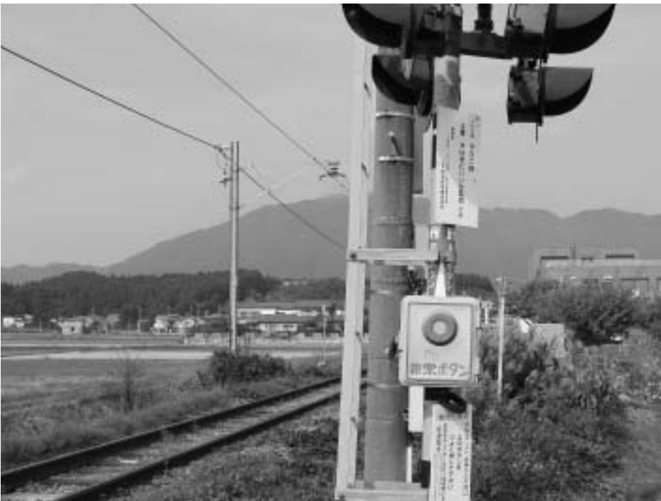
要望している非常用ボタン
