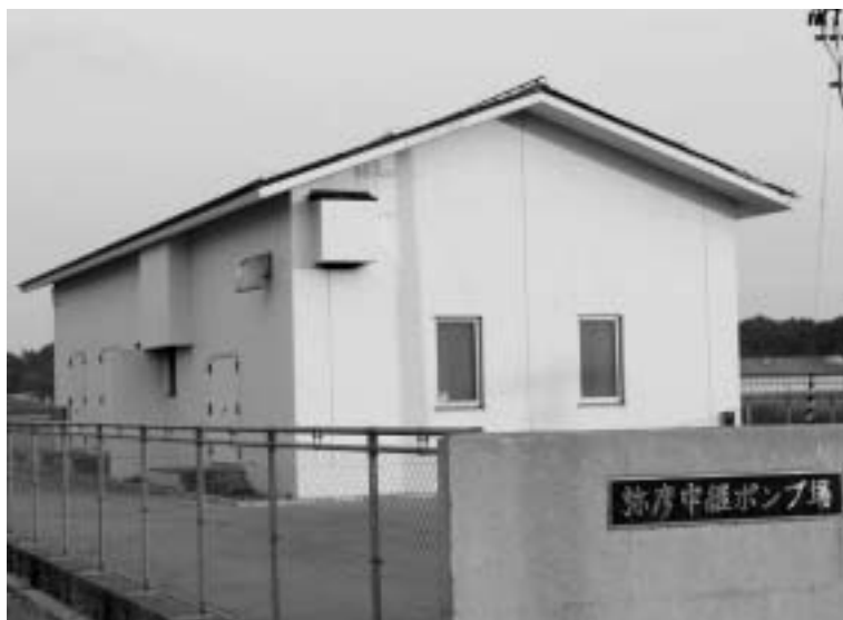
井田地内にある下水道中継ポンプ場
