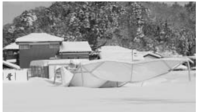
倒壊したテント
