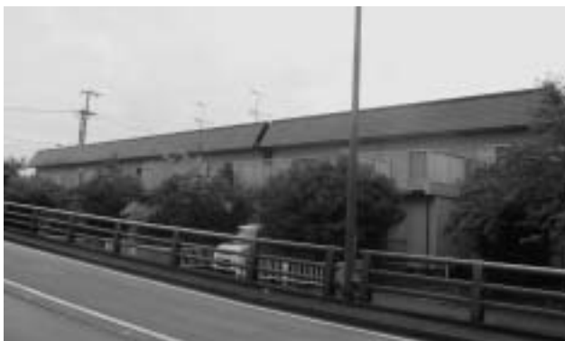
人口増につながるか・・・村営住宅建設
