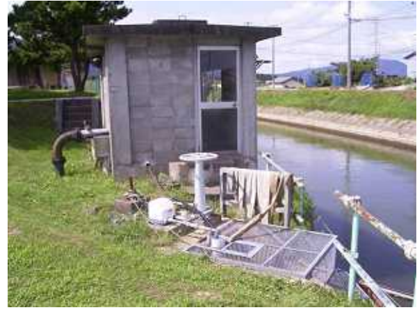
西川取水口近景
