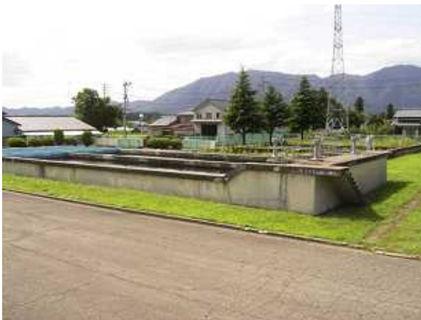
第 1 薬品沈殿池全景
