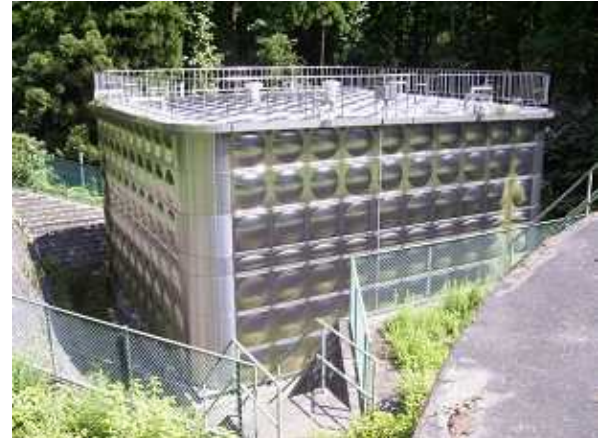
高区ステンレス配水池
