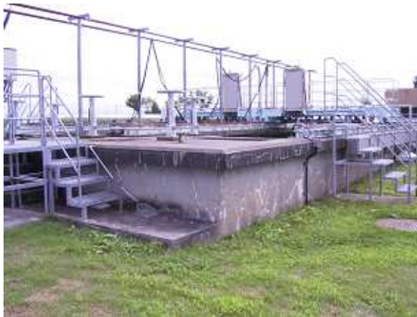
第2薬品沈殿池全景
