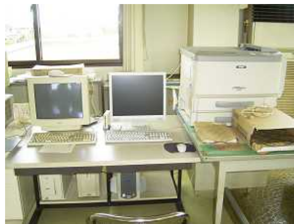
監視室計装機器
