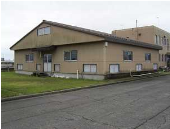
急速ろ過池全景
