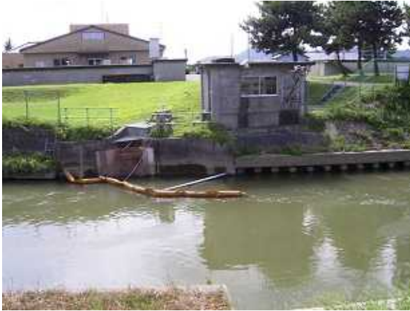
西川取水口全景
