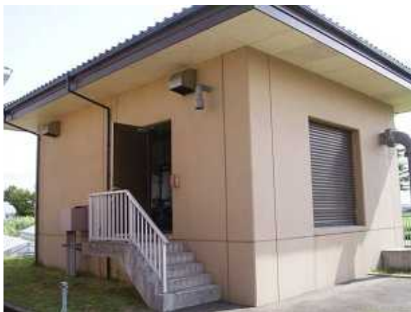
送水ポンプ室全景
