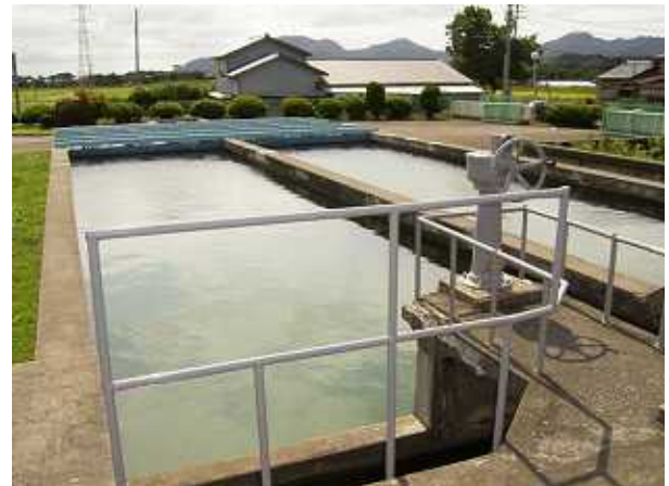
第 1 薬品沈殿池近景
