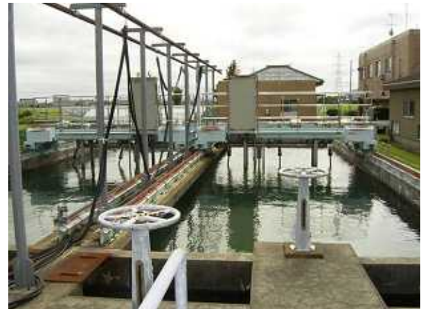
第2薬品沈殿池近景
